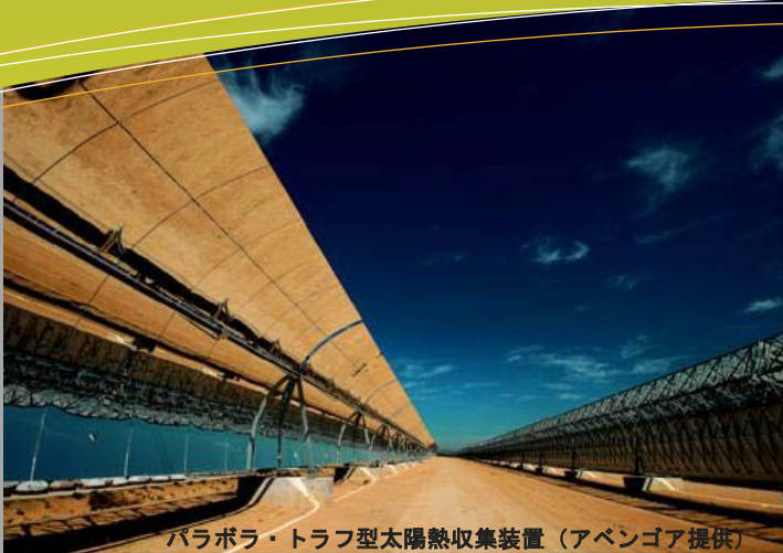
パラボラ・トラフ型太陽熱収集装置 (アベンゴア提供)
